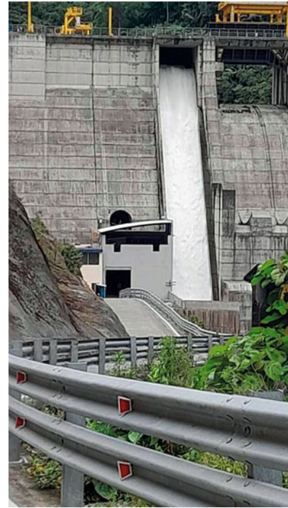
Рис. 7. Поверхностный ступенчатый водосброс и здание мини-ГЭС
